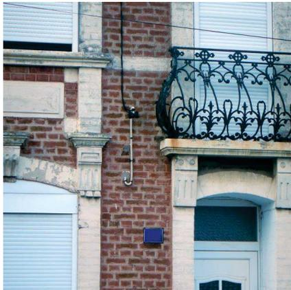
Exemple d'arrivée aérienne à travers un mur. Le boîtier EDF interne est très probablement situé à gauche de la porte d'entrée.
