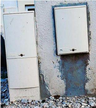
Quelques exemples de boîtiers : Enedis (plus récents, à gauche) et EDF (à droite). A ne pas confondre avec les boîtiers d'arrivée de gaz, ornés d'une flamme.
