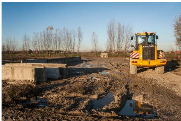
Un cantiere in zona San Donato, Bologna, nel novembre del 2016. (Michele Lapini)
