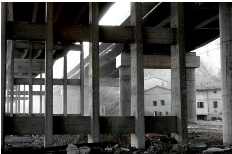
Viadotto della Variante di Valico in località La Quercia (BO), uno degli "hubs a bassa velocità" del progetto partecipativo in Val di Setta – Foto di Giuditta Pellegrini, 2012.
